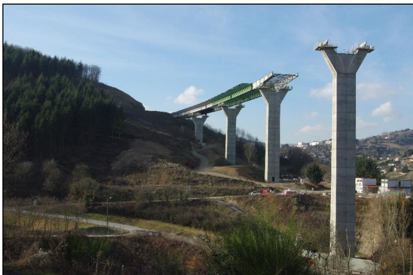
Construction du viaduc de Goutte Vignole à Saint-Marcel-l'Eclairé sur l'autoroute A89.
